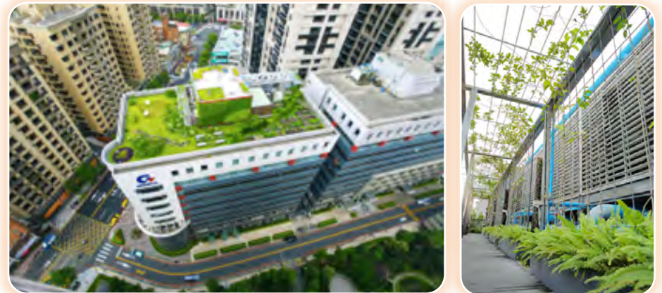
(圖)總部大樓屋頂建置雨水回收系統 (G-HOME 技嘉科技永續生態屋頂)
