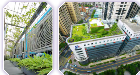
總部大樓屋頂建置雨水回收系統(G-HOME 技嘉科技永續生態屋頂)
